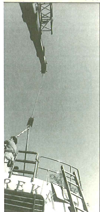
Mast aufgelegt. hut
